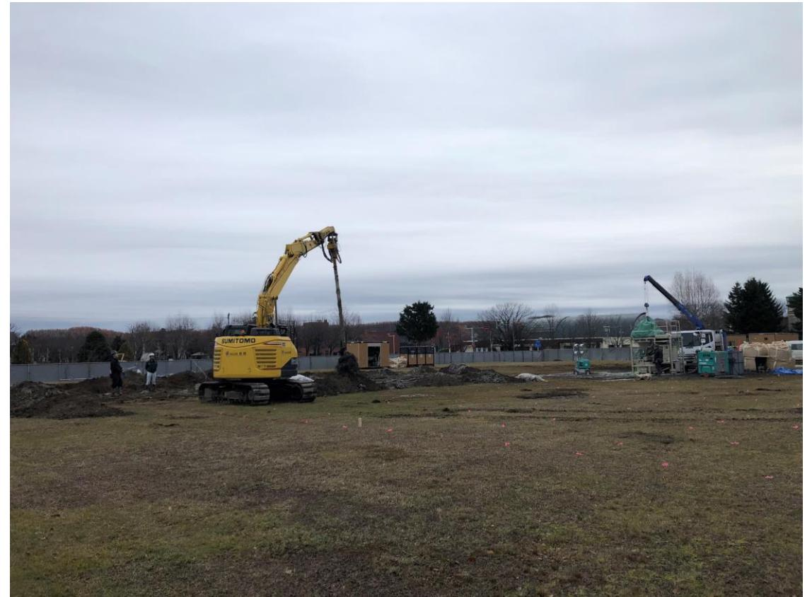
②重機で地盤改良のための掘削作業が行われています。
