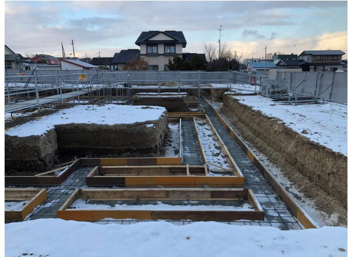
④型枠に鉄筋を組み立てていきます。木の型枠はコンクリート打設後に撤去されます。
