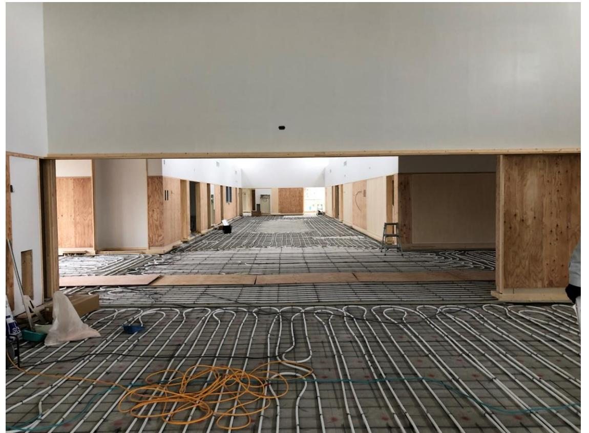
②【6月上旬】床に管（白部分）を布設します。管に温水を流し床面を温めます。
