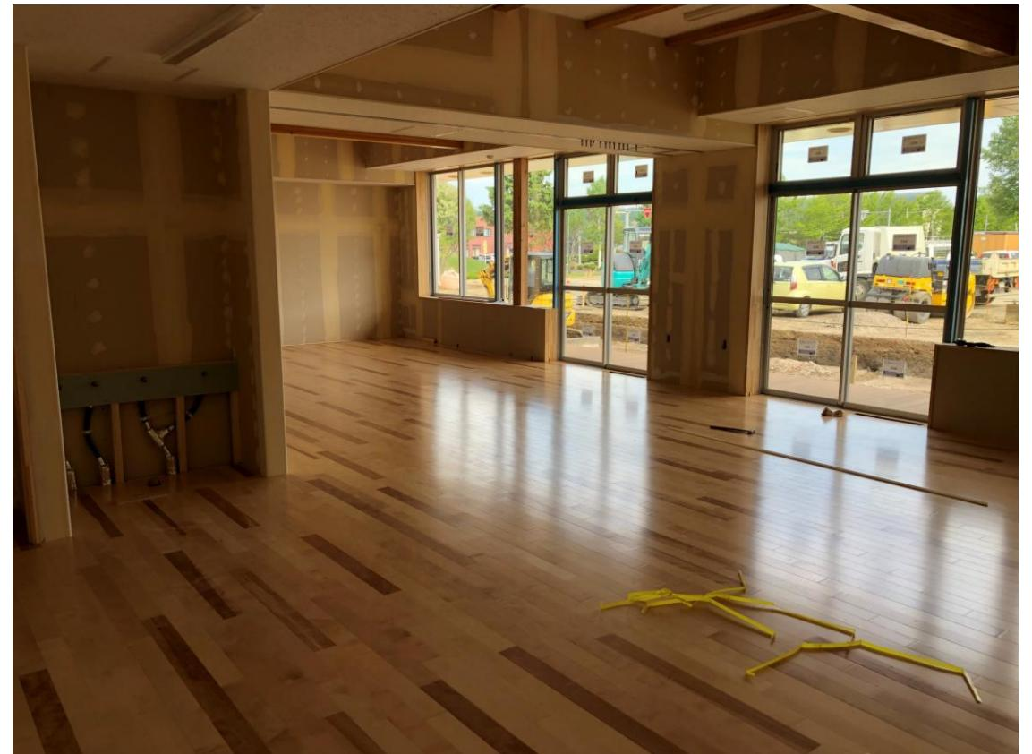
⑤事務室の床は電源位置を調整できるOAフロアとなります。（左写真）施工前 （右写真）施工後
